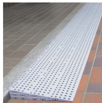
外部にも使用でき、乗用車が通過しても耐えられる強度をもっています。
