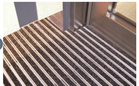
⑥ 上部マットの端部をカットして交換作業は完了です。
