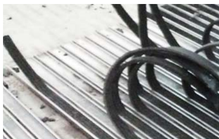
① 傷んで古くなった上面マット部分を取り除きます。
