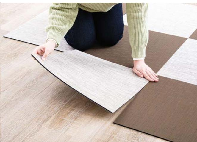
裏面の保護シートを剥がし設置してください。
